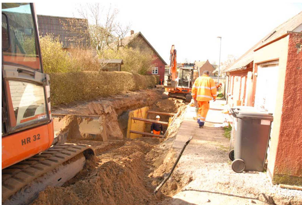
Kloakfornyelse i Råby.
