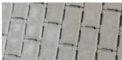
Eksempel på permeabel belægning - betonsten med drænfuge. Kilde: temablad, Lokal håndtering af regnvand, Dansk Beton
